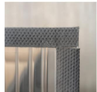
Ein Führungsprofil für Platten zur Hand nehmen und auf die Kante der Strukturkammerplatte aufstecken. Dann mit einem Bleistift die Kante vorsichtig nachzeichnen. Diesen Schritt bei allen Platten ringsum wiederholen
